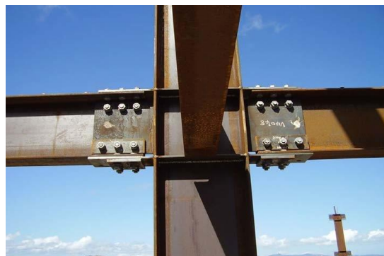
Фигура 2.7 – Възел с плъзгаща се става с асиметрични фрикционни демпфери - Te Puni Village, Уелингтън, Нова Зеландия [13]
