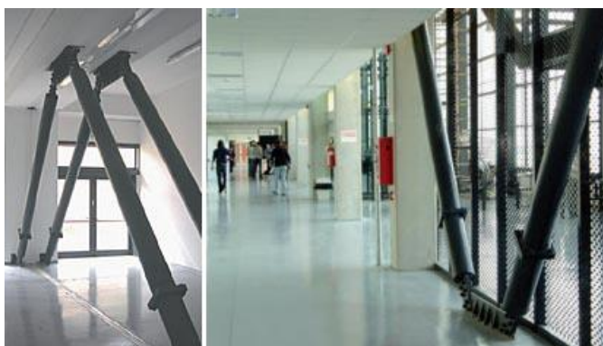
Фигура 2.2 – Диагонали с предотвратено изкълчване, инсталирани в сглобяема стоманобетонна конструкция в Анкона, Италия (с позволението на FIPMEC srl)
