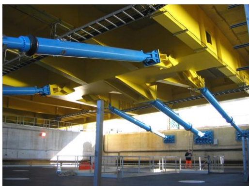
Фигура 2.1 – Вискозни демпфери на моста Рион – Антирион, Гърция (с позволението на FIPMEC srl)
