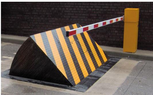
Figure 8. Bloqueur de route automatique et barrière
