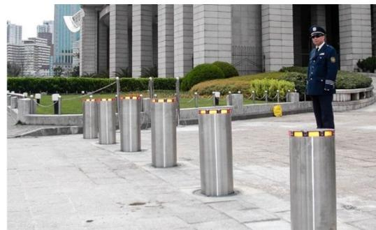
Figure 9. Bloqueurs hydrauliques de sécurité routière
